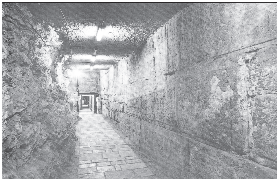
Figura 4: Parte sud del tunnel del Muro Occidentale; il muro del Monte del Tempio erodiano si trova sul lato destro.
